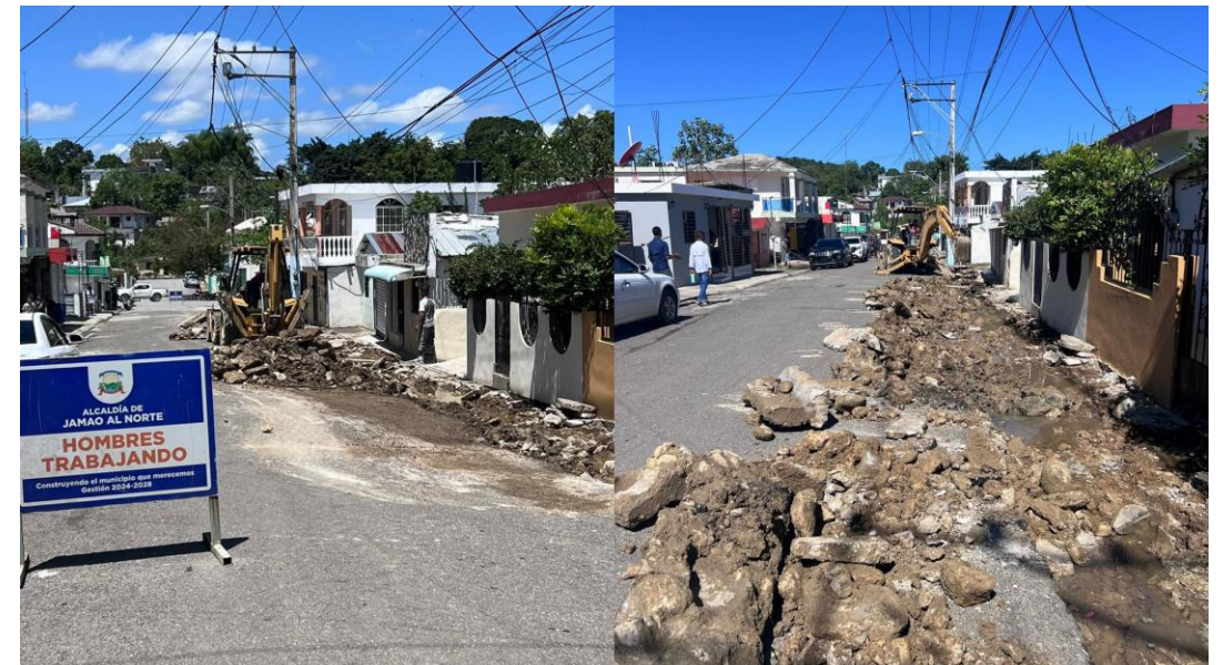
Fotos construcción de aceras y contenes
