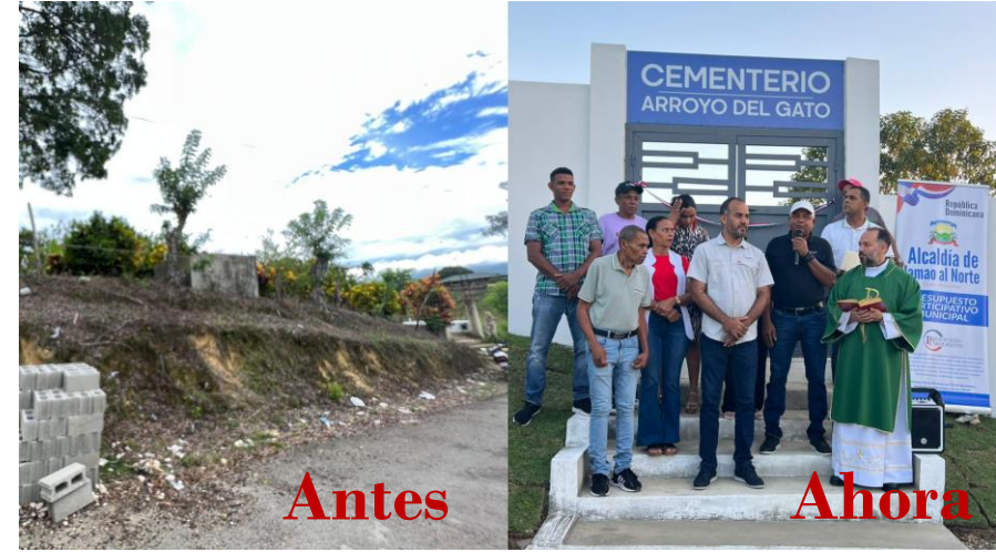
Foto #2 Verja perimetral del Cementerio de Arroyo del Gato
