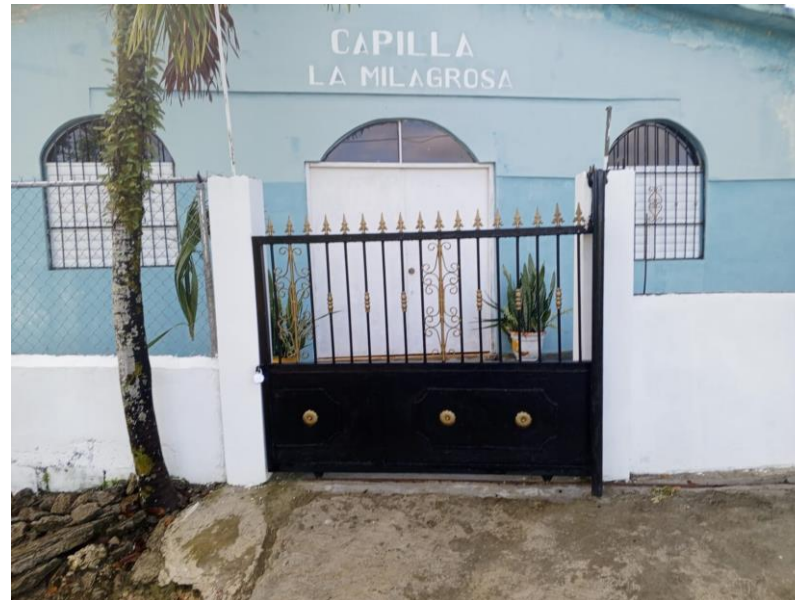
Construcción Verja Capilla La Milagrosa "Palo Blanco"
